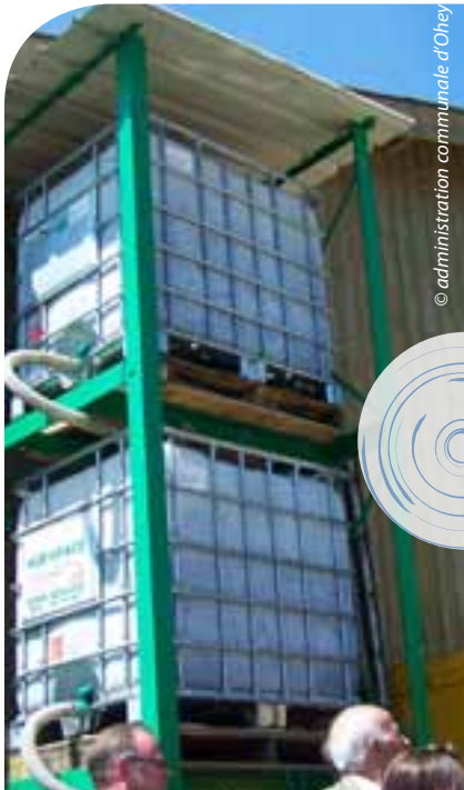
Biofiltre installé chez un agriculteur à Ohhey et permettant le traitement des résidus de pulvérisation
