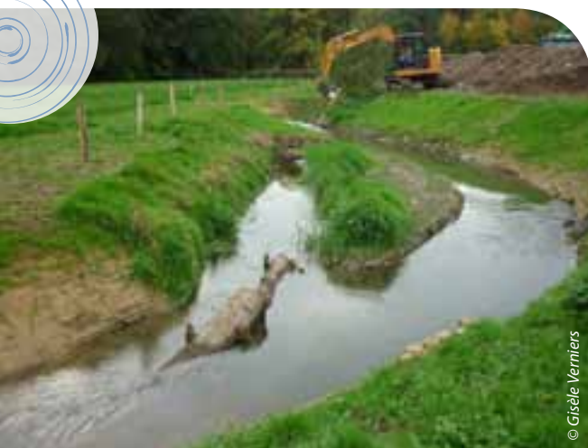
Le Leignon à Ciney : réaménagement du ruisseau et ancien lit conservé en bras mort. Les bois dans l'eau contribuent à la diversification des courants et l'enrichissement des habitats aquatiques
