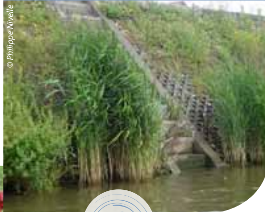
Revégétalisation réalisée à la base des berges de la Meuse entre Namur et Andenne. Cet essai fructueux sera reconduit dès 2011 le long d'autres tronçons du fleuve
