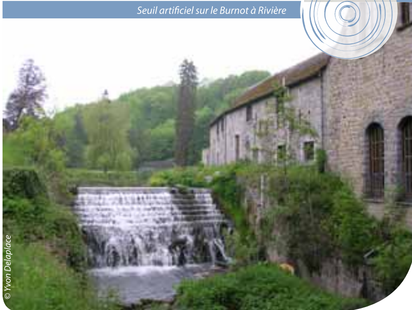
Seuil artificiel sur le Burnot à Rivière
