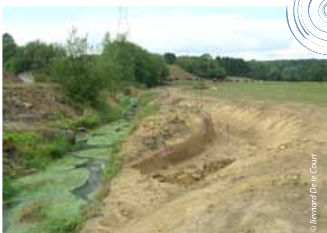
Le Leignon à Ciney : réaménagement du ruisseau et ancien lit conservé en bras mort. Les bois dans l'eau contribuent à la diversification des courants et l'enrichissement des habitats aquatiques
