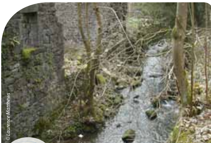
Effondrement d'un mur dans le lit du Ruisseau de Leffe à Dinant
