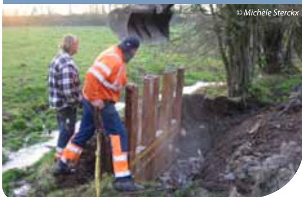
Travaux d'aménagement d'une aire d'accès pour le bétail le long d'un petit cours d'eau non classé à Gesves
