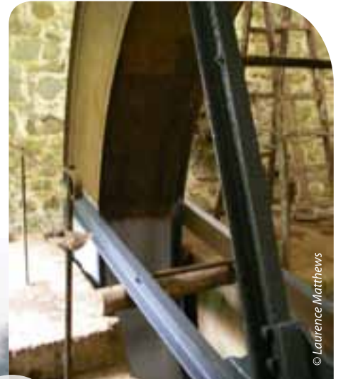
La station de pompage de Fechelenne en rénovation à Falaën le long du Flavion
