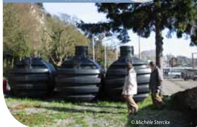
Unités d'épuration autonome prêtes à être installées au domaine militaire de Marche-les-Dames
