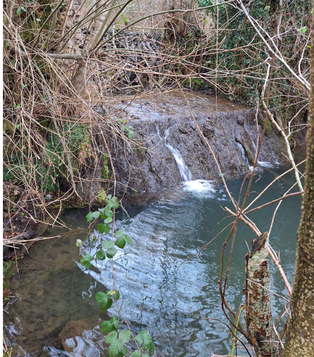
Le projet d'effacement du seuil vise à rétablir la continuité écologique de la rivière
