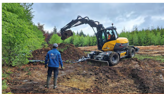
Excavation des terres contaminées le 5 mai 2026 à proximité de la Tour du Millénaire avec l'aide de la Commune de Gedinne
